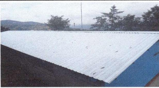
Foto 1: Sustitución de lámina por lámina troquelada aluzinc calibre 26 en aulas del modulo 1
