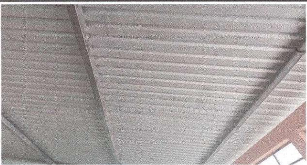
Foto 5: Sustitución de estructura de metal en aulas del modulo 1
