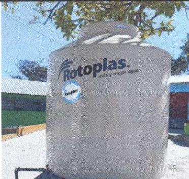
Foto 3: Sustitución de depósito de agua de 1100 litros, para el modulo 1
